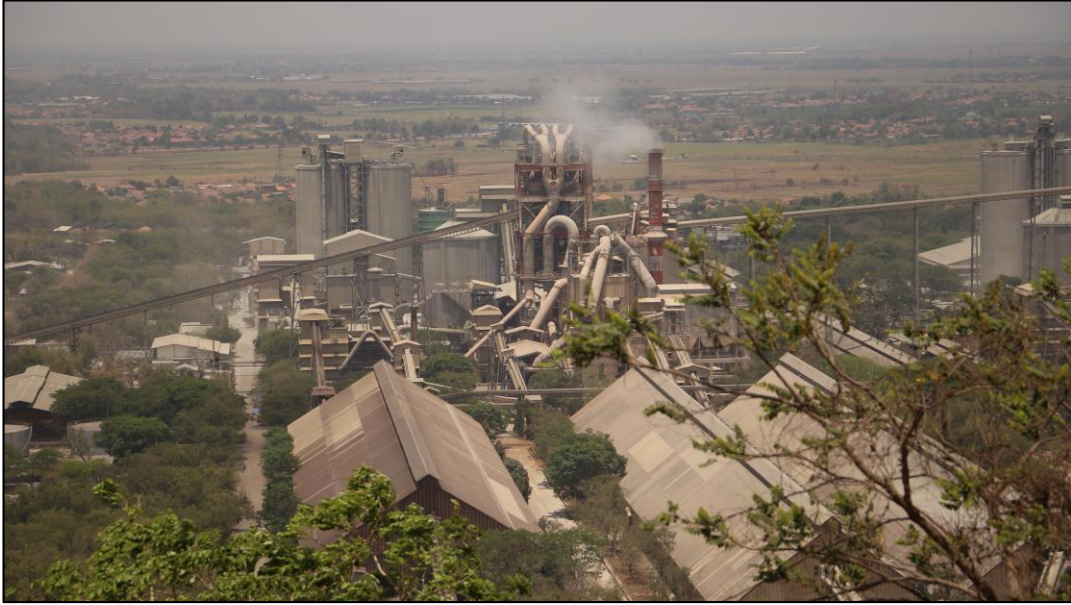
Plant Area Pabrik Pembuatan Semen PT. Indocement Tunggal Prakarsa Tbk.
